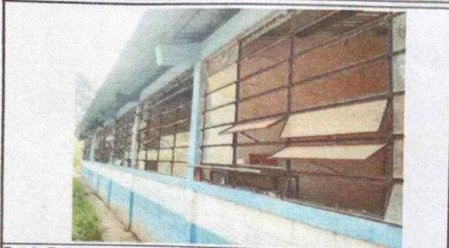
Foto 1: En la imagen se observa las ventanas con vidrios quebrados de todo el edificio escolar.
