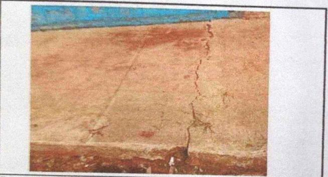
Foto 3: En la imagen se observa las grietas del corredor del establecimiento
